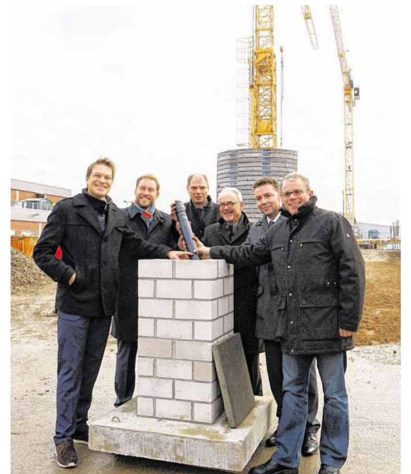
Grundsteinlegung für den Neubau des Jobcenters: Gerhard Wittfeld (Architekt), Jens Kreiterling (Landmarken), Prof. Manfred Sicking (Stadt Aachen), Helmut Etschenberg (Städteregionsrat), Jürgen Koch (Agentur für Arbeit) und Stefan Graaf (Geschäftsführer des Jobcenters) setzen auf die zentrale Kooperation. Foto: Andreas Steindl
